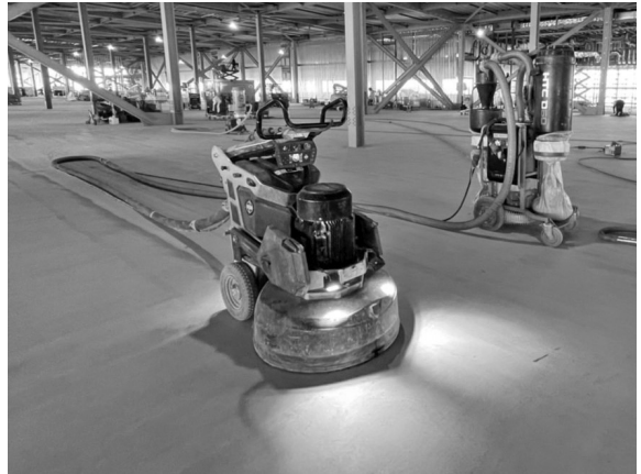
写真2 「メクレーンポリッシュ工法」に用いる研磨機と集塵機
